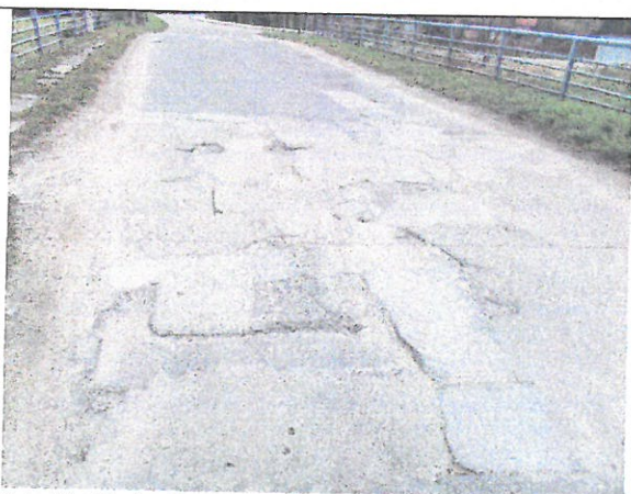
Fot. 13. Uszkodzenie nawierzchni dojazdu od strony miasta, ślady po remontach częściowych, deformacje
