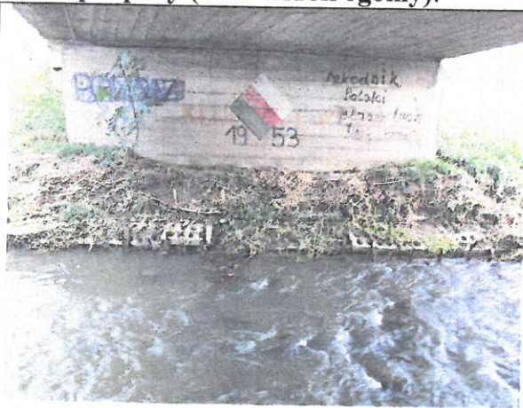
Fot. 7 Widok ogólny podpory, graffiti, uszkodzenie umocnienia brzegowego
