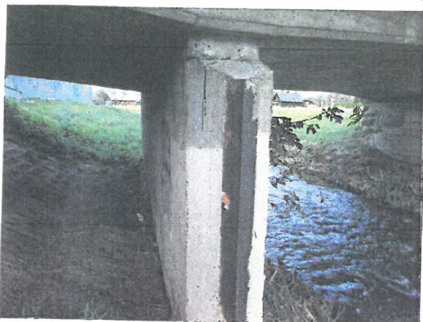
Fot. 5 Widok czołowej części podpory Nr 1, korozja elementu stalowego
