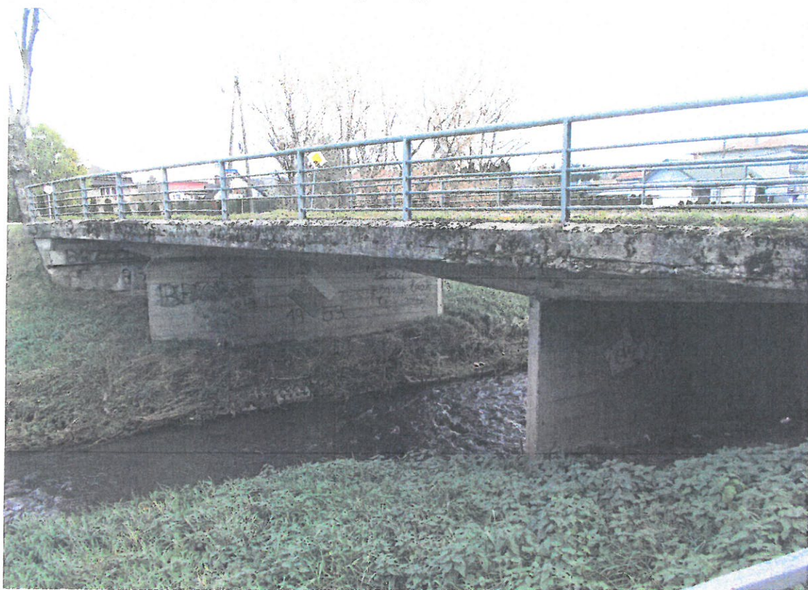
Fot. 1 Widoczne uszkodzenia belki podporęczowej, ubytek w przęśle balustrady, uszkodzenie linii brzegowej
