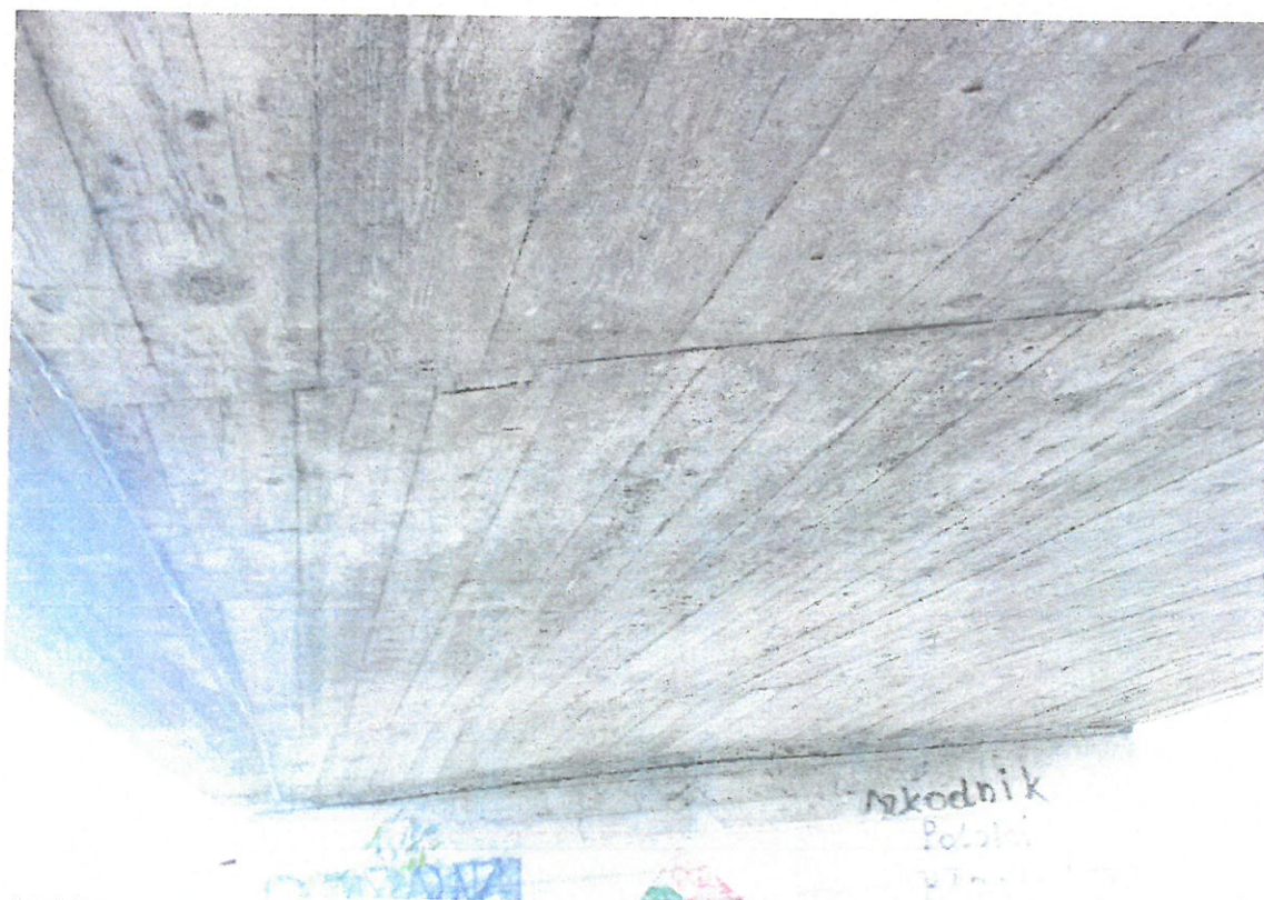
Fot. 4 Widoczne rakowiny po zdjęciu deskowania płyty pomostowej, punktowe oznaki korozji prętów zbrojeniowych
