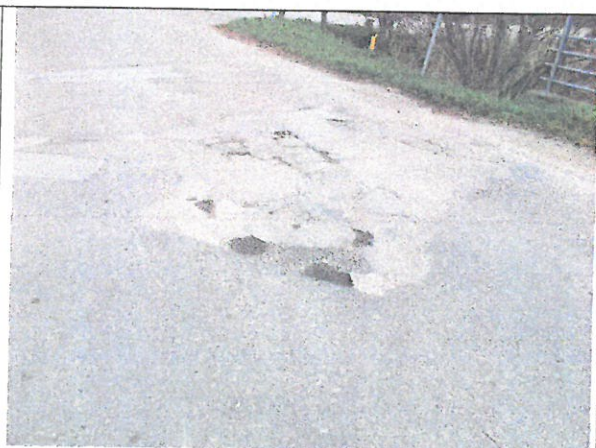
Fot. 14. Uszkodzenie nawierzchni dojazdu od strony dzielnicy „Borkówka”, ubytki nawierzchni
