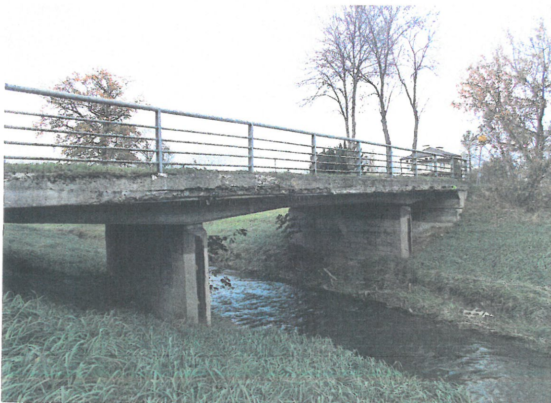
Fot. 2 Widoczne uszkodzenia belki podporęczowej i gzymsu, uszkodzenie linii brzegowej
