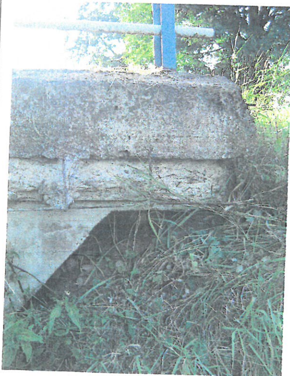
Fot. 25. Erozja skarpy i odsłonięte skrzydełko nad podwaliną nr 1, widoczne ubytki betonu gzymsu i odsłonięte zbrojenie
