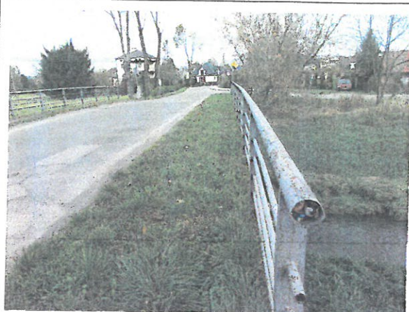
Fot. 12 Widok prawego chodnika, zarośnięta nawierzchnia chodnika, odchylona balustrada
