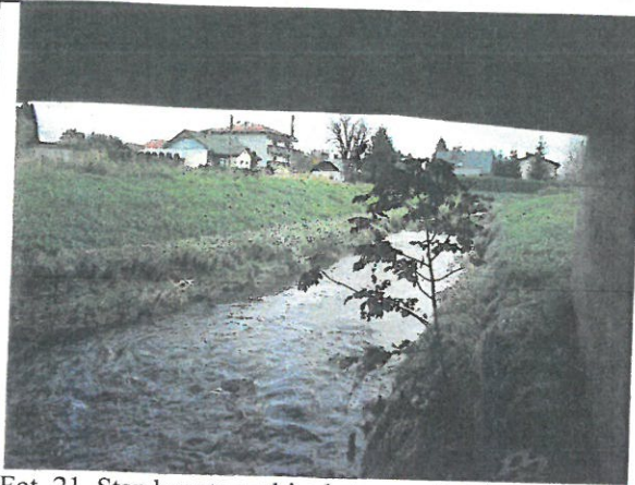
Fot. 21. Stan koryta rzeki od strony górnej wody, rozmycia i roślinność
